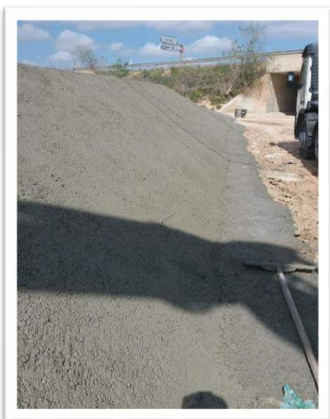
Evitando de ésta manera los desprendimientos de tierras y la aparición de hendiduras debido a las lluvias
