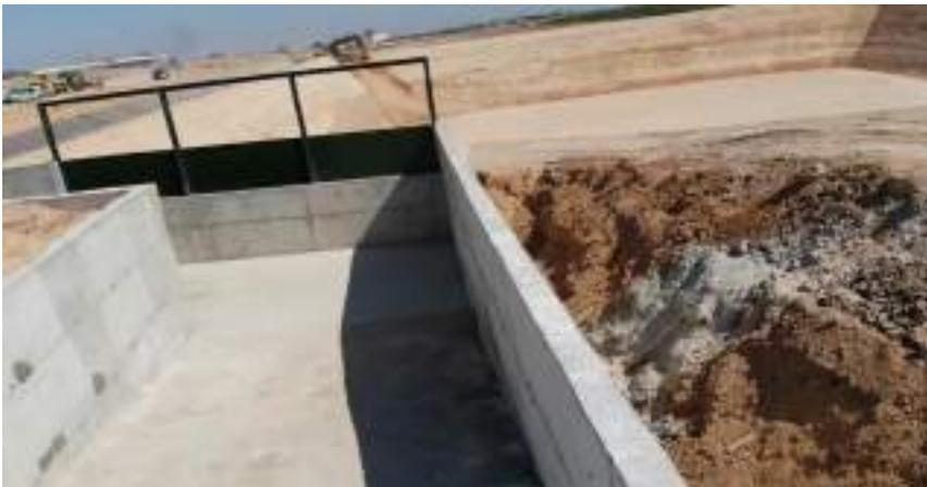
Y como no , para evitar su desbordamiento, la realización de un canal de desagüe, para desviar nuevamente el agua una vez llenado el embalse.
