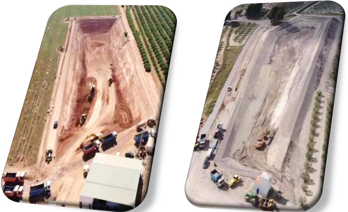
Calculamos las medidas de la superficie que el cliente nos proporciona y en base a la capacidad que desea obtener, diseñamos su embalse, ajustando la pendiente de los taludes, la profundidad y el pasillo de coronación, siempre sin descuidar el mínimo detalle en el vaso, quedando la zona en perfectas condiciones para su impermeabilizado.
